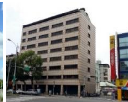
福全新整棟 客戶:救國團 面積:1,271坪(全棟)
