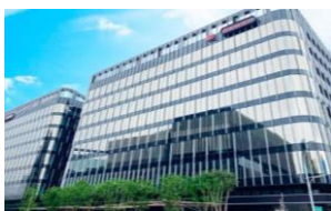
內湖長虹新世代大樓 客戶:萬海航運 面積:6,744坪 (A.B全棟)
