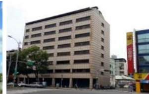
福全新整棟 客戶:救國團 面積:1,271坪 (全棟)
