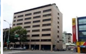
福全新整棟 客戶:救國團 面積:1,271坪(全棟)
