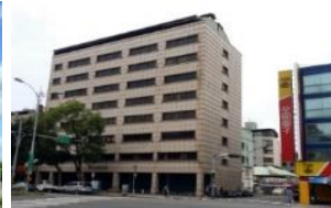
福全新整棟 客戶:救國團 面積:1,271坪(全棟)
