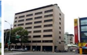
福全新整棟 客戶:救國團 面積:1,271坪(全棟)
