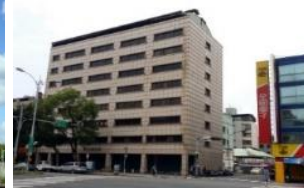
福全新整棟 客戶:救國團 面積:1,271坪(全棟)
