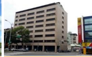
福全新整棟 客戶:救國團 面積:1,271坪(全棟)
