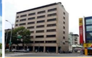
福全新整棟 客戶:救國團 面積:1,271坪(全棟)
